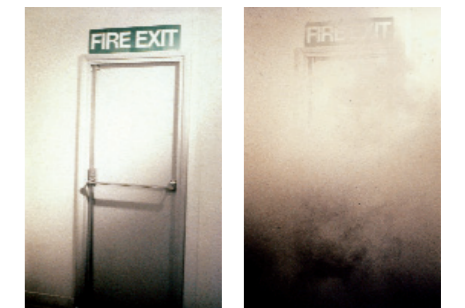
Rauch kann sich mit über 2m/s fortbewegen. Das ist schneller als die voraussichtliche Fluchtgeschwindigkeit der Menschen im Gebäude.
